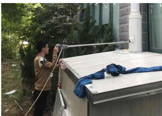
现场检测照片
